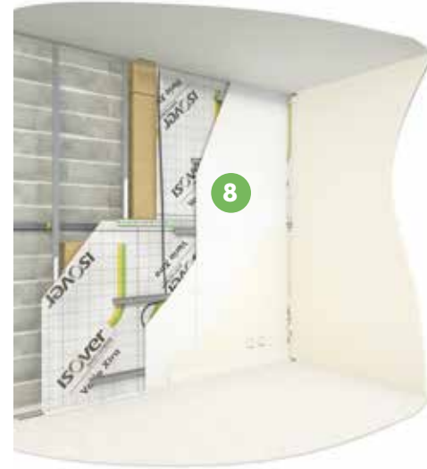
8 Fixation de la plaque de plâtre
